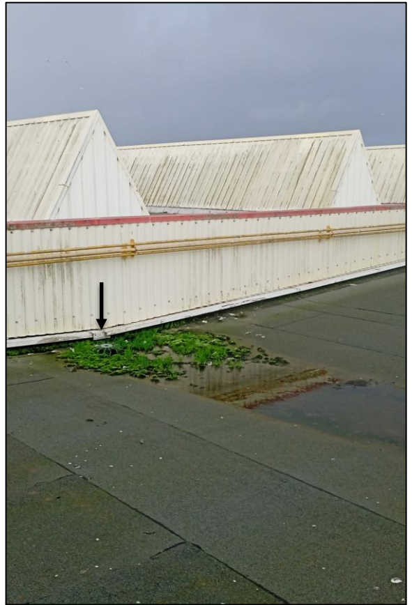
Figure 3. Illustration de naissances d'eaux pluviales à reprendre
