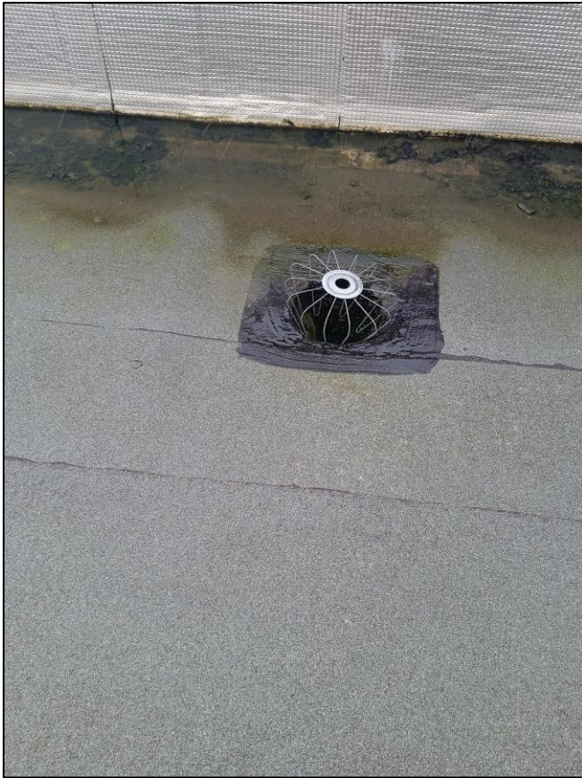
Figure 3. Illustration de naissances d'eaux pluviales à reprendre
