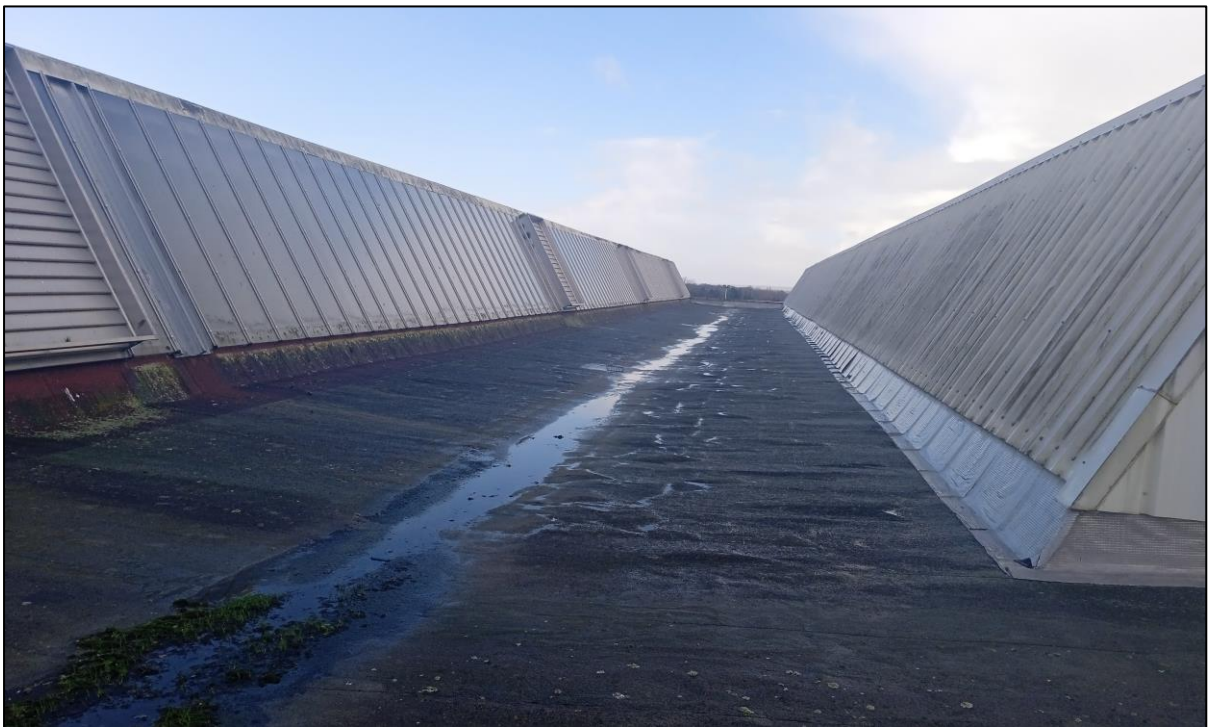
Figure 4. Vue de la toiture et des secteurs de reprise d'étanchéité (pied de shed et surface en bicouche)
