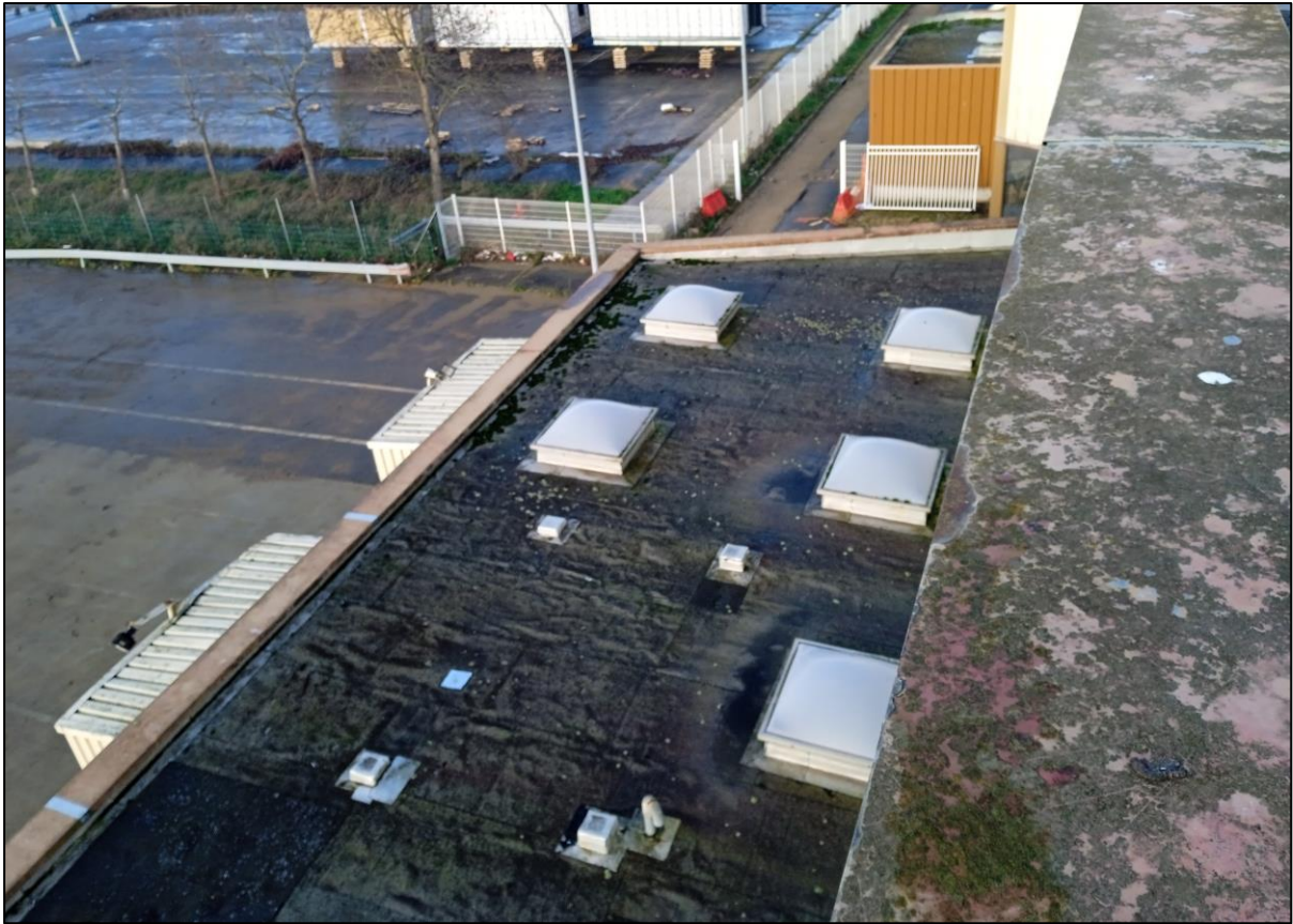
Figure 5. Vue de l'une des annexes qui sera démolie
